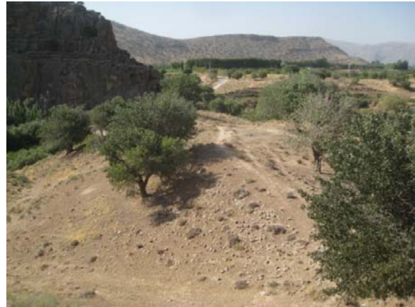
تصویر ۲۵. نمای کلی از بند بلاغی دید از شمال
