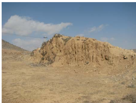
تصویر ۲۹. هسته خاکی سد که بخش زیادی از آن تخریب شده است.
