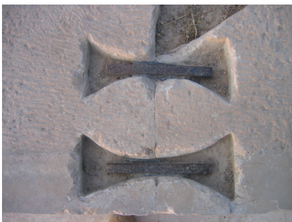
تصویر ۴. بست‌های فلزی دم چلچله‌ای کاخ بار عام پاسارگاد
