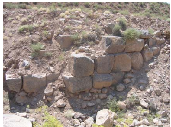
تصویر ۱۱. بخشی از سازه سنگی خشکه‌چین سد تنگ حنا ۲ (زارعی و کرمی، ۱۳۸۶)
