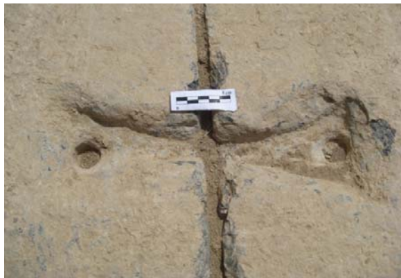
تصویر ۳. نمونه‌ای از بست‌های دم چلچله‌ای سازه سد ۱ تنگ حنا
