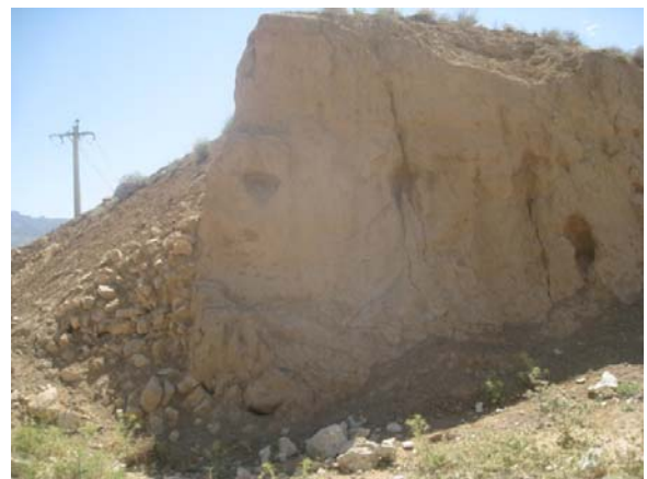
تصویر ۳۴. جزئیات دیواره سد با هسته خاکی و بدنه لاشه‌سنگی
