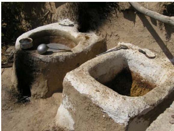
تصویر ۵۳. سازه ساروجی (گرشک) دوره معاصر مربوط به کارگاه تولید شیر انگور در دشت کمین (آرشیو پارسارگاد)
