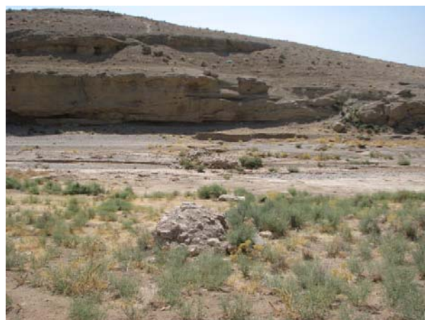
تصویر ۲۳. باقی‌مانده پایه‌های پل با مصالح سنگ لاشه و ملات ساروج در مسیر بند- راه دم دریا، بستر رودخانه پلوار
