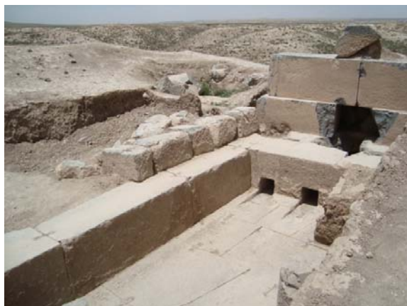
تصویر ۱۳. بخشی از حوضچه آرامش در انتهای خروجی‌های شش- گانه (اسدی و بوشارلا ۱۳۸۸)
